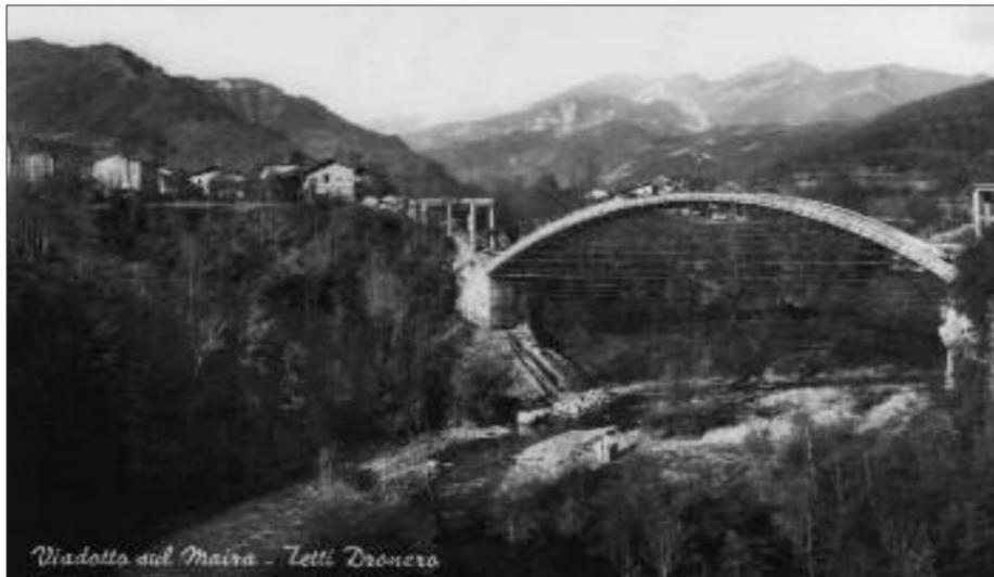
Impalcature per la costruzione del ponte di Ponte di Tetti, 1956
