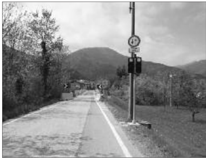
Il Ponte di Tetti, ora a circolazione alternata, da mettere in sicurezza
