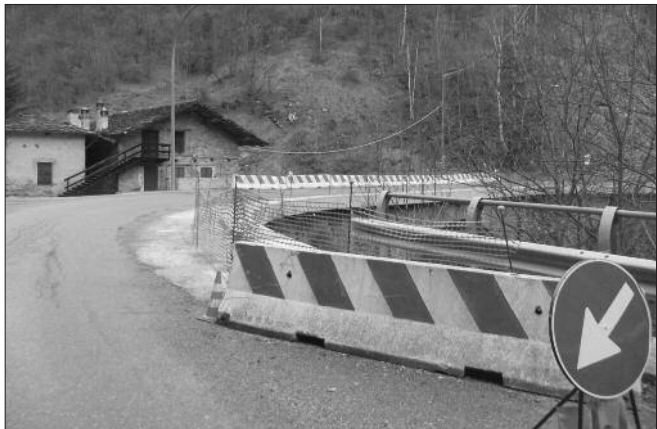
Lavori sulla SP422 a Stroppa
