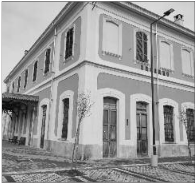
Stazione di Dronero
