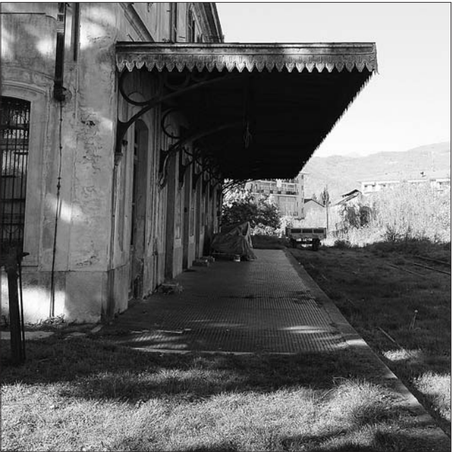
La Pensilina. Da qui transitavano i treni
