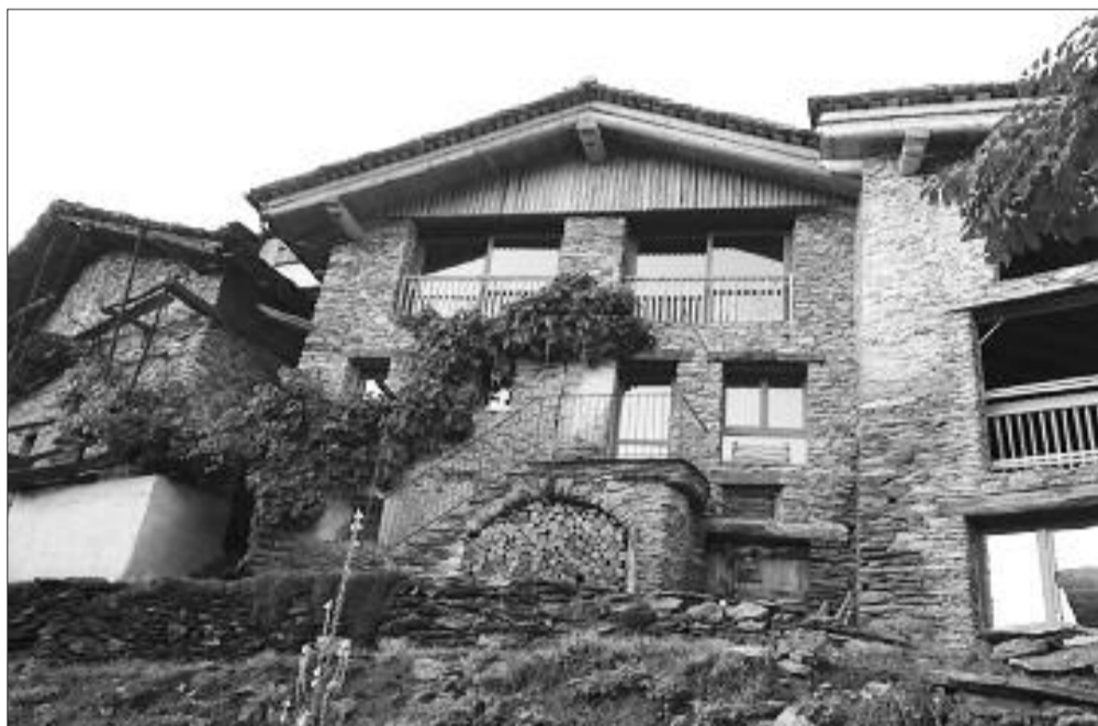
Interventi di ristrutturazione e conservazione a San Martino
