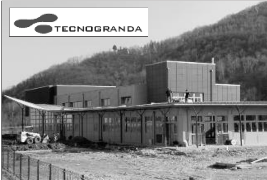
La sede di Tecnogranda in costruzione
