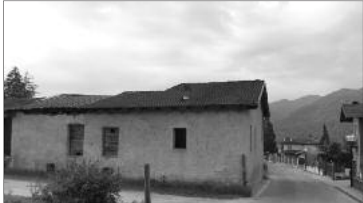
Strada dei Catari, la casa da demolire
