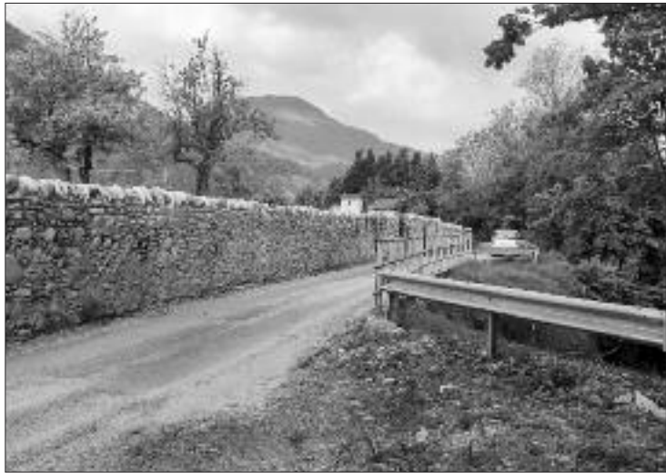
Nella foto i lavori di consolidamento eseguiti
