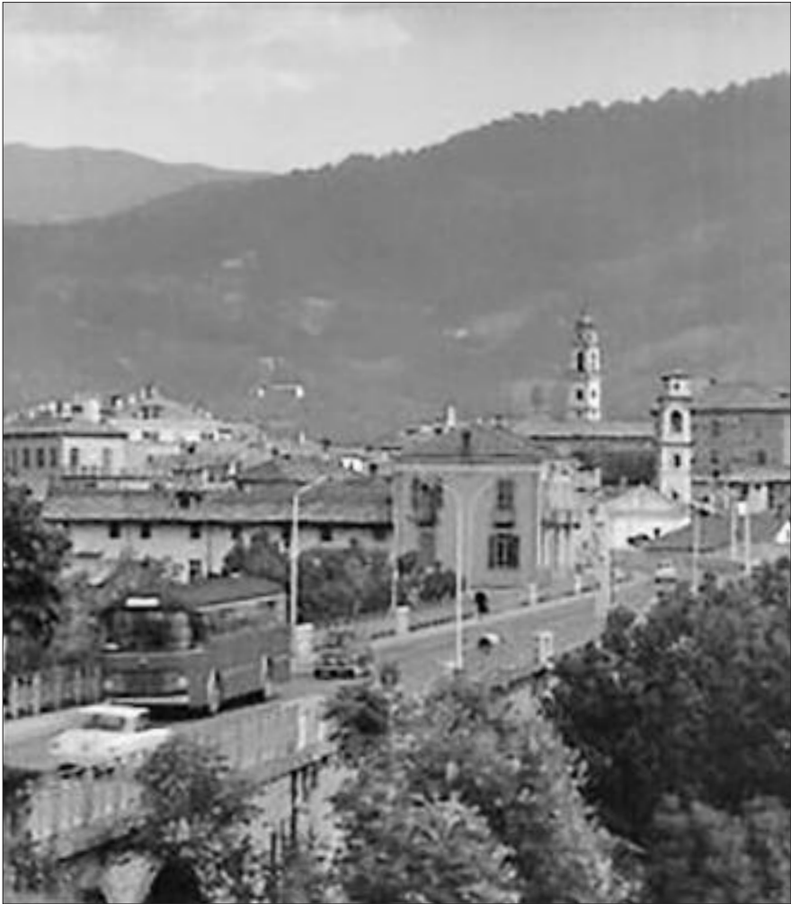
Dronero, il Ponte nuovo anni '60
