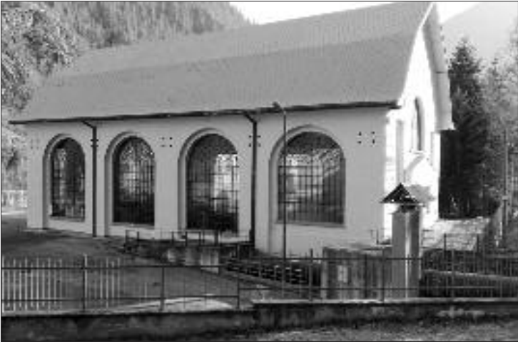
La centrale di Acceglio
