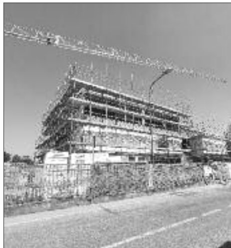
Il cantiere aperto della scuola Oltre Maira
