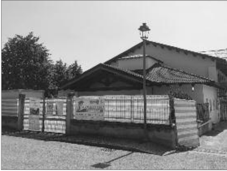
I lavori quasi completati alla sala polivalente
