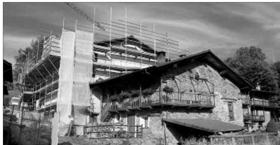
Uno dei cantieri PNR di Elva
