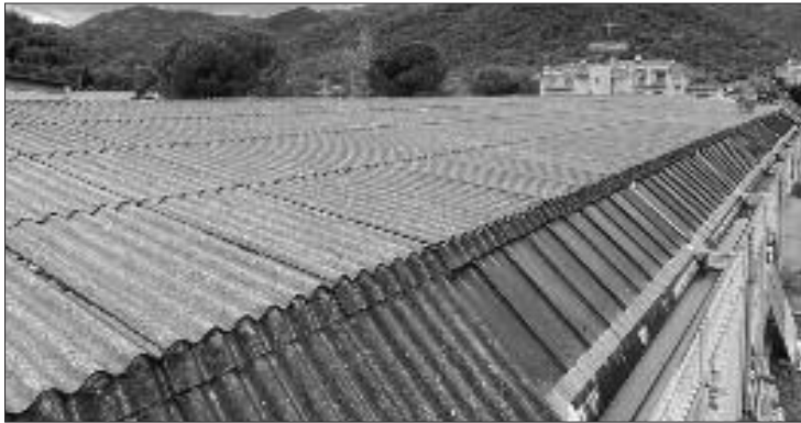
Particolare della copertura da smaltire
